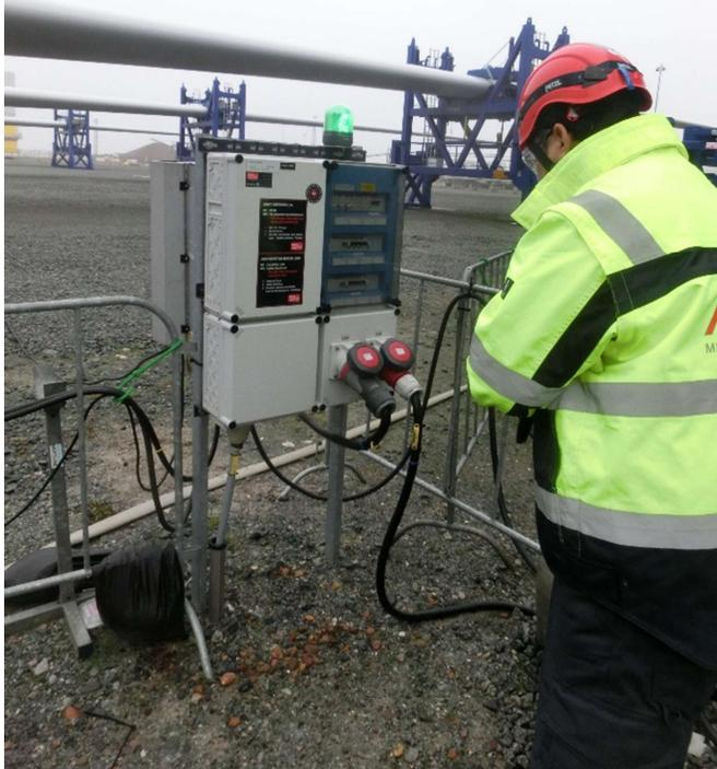
港湾内のナセル置き場には、機器の作動試験ができるように数十m置きに配電されている。
