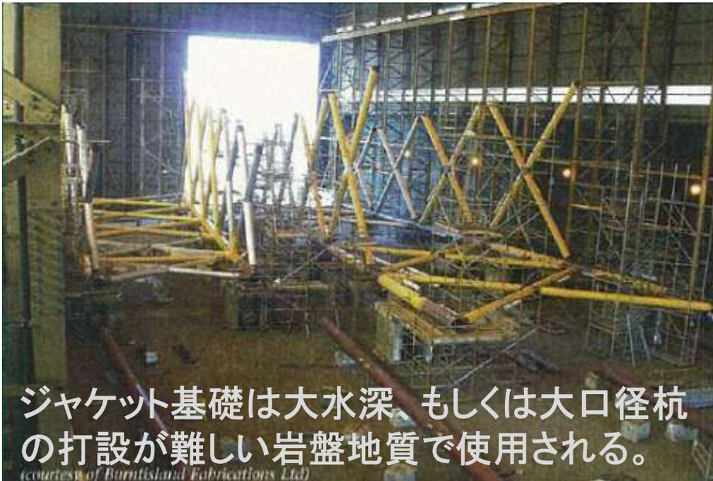
ジャケッ基礎は大水深、もしくは大口径杭の打設が難しい岩盤地質で使用される。
