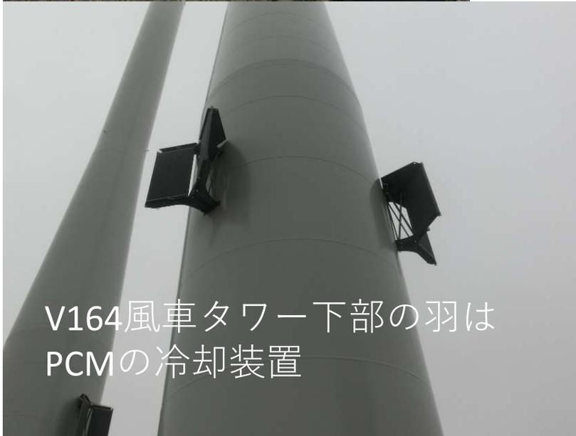
V164風車タワー下部の羽はPCMの冷却装置
